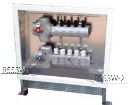
Установленный в шкаф коллектор с теплоизолирующими оболочками.
